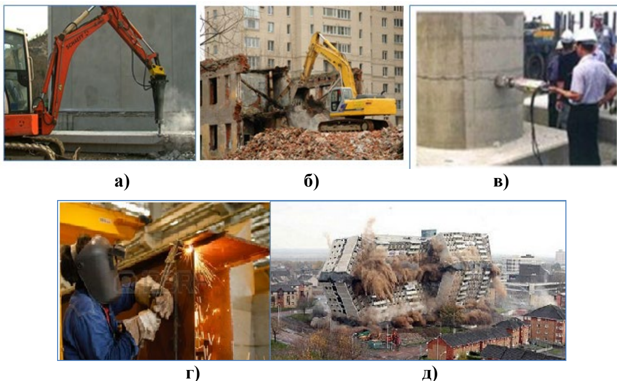
Рис. 2 Примеры сноса здания с помощью а) гидромолота, б) экскаватора, в) гидравлического расклинивающего устройства, г) газовой резки, д) взрыва
