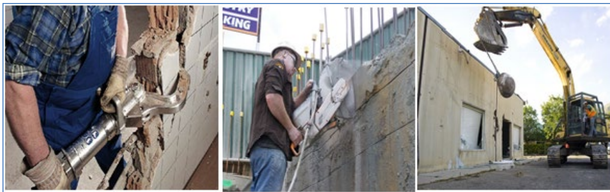
Рис. 1 Примеры механического демонтажа
